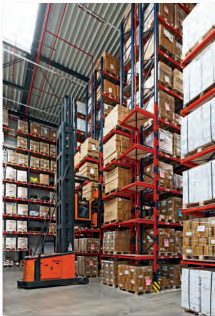
L'entrepôt de grande hauteur
