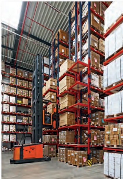
L'entrepôt de grande hauteur
